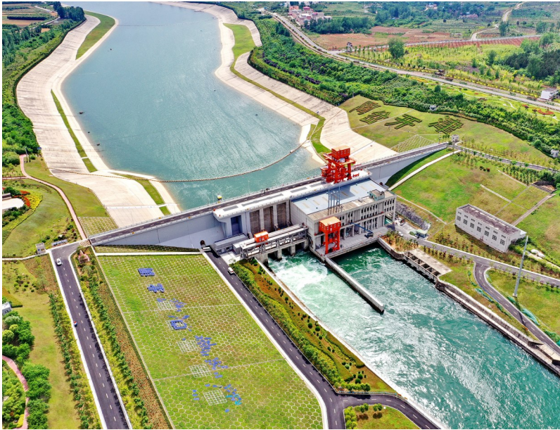
截至2022年7月22日,南水北调中线一期工程陶岔渠首入总干渠水量突破500亿立方米 李先明 摄
