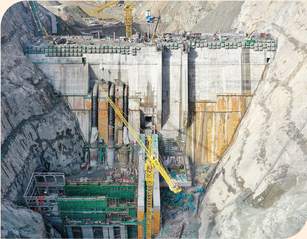
黑河黄藏寺水利枢纽工程大坝主体浇筑至2606米高程
