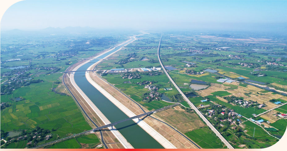
引江济淮工程实现试通水试通航
