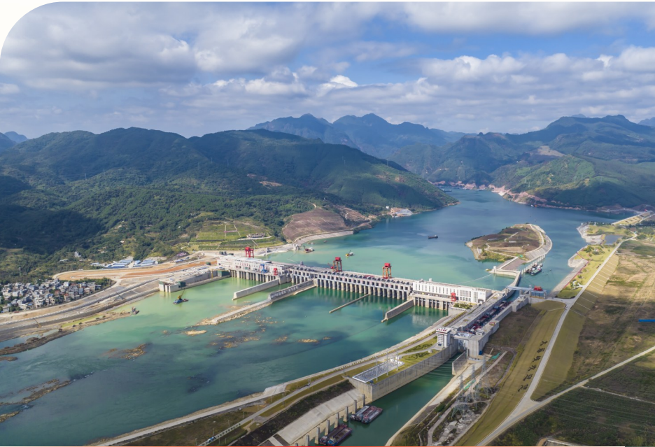
西江大藤峡水利枢纽
