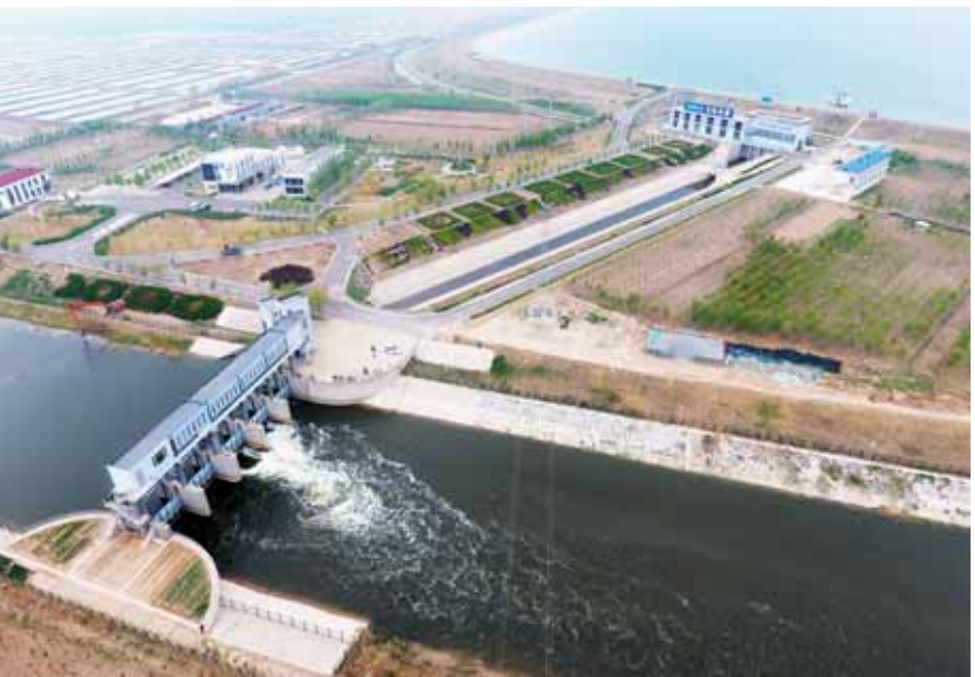
南水北调东线一期北延应急试通水
