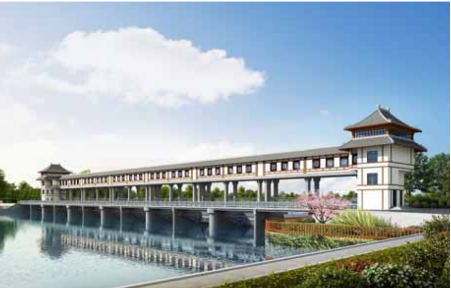
四女寺枢纽北进洪闸除险加固工程完工
