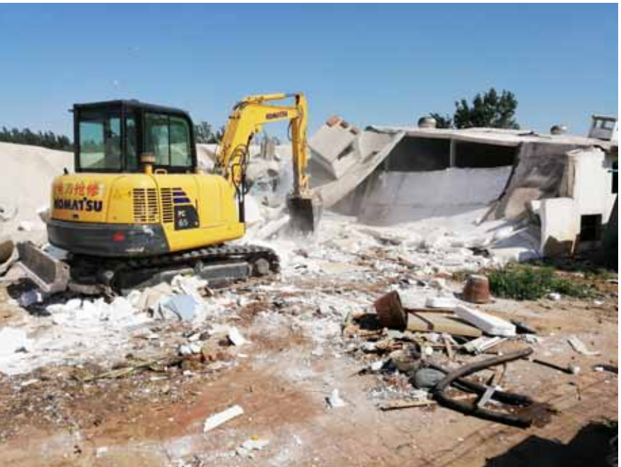
“清四乱”拆除违建
