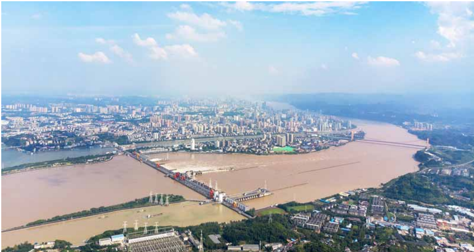
2020年汛期,长江干流先后发生5次编号洪水,包括三峡、葛洲坝在内的长江上中游水库群合计拦洪约490亿立方米,有效缓解了下游城市的防洪压力。图为葛洲坝水利枢纽工程。
