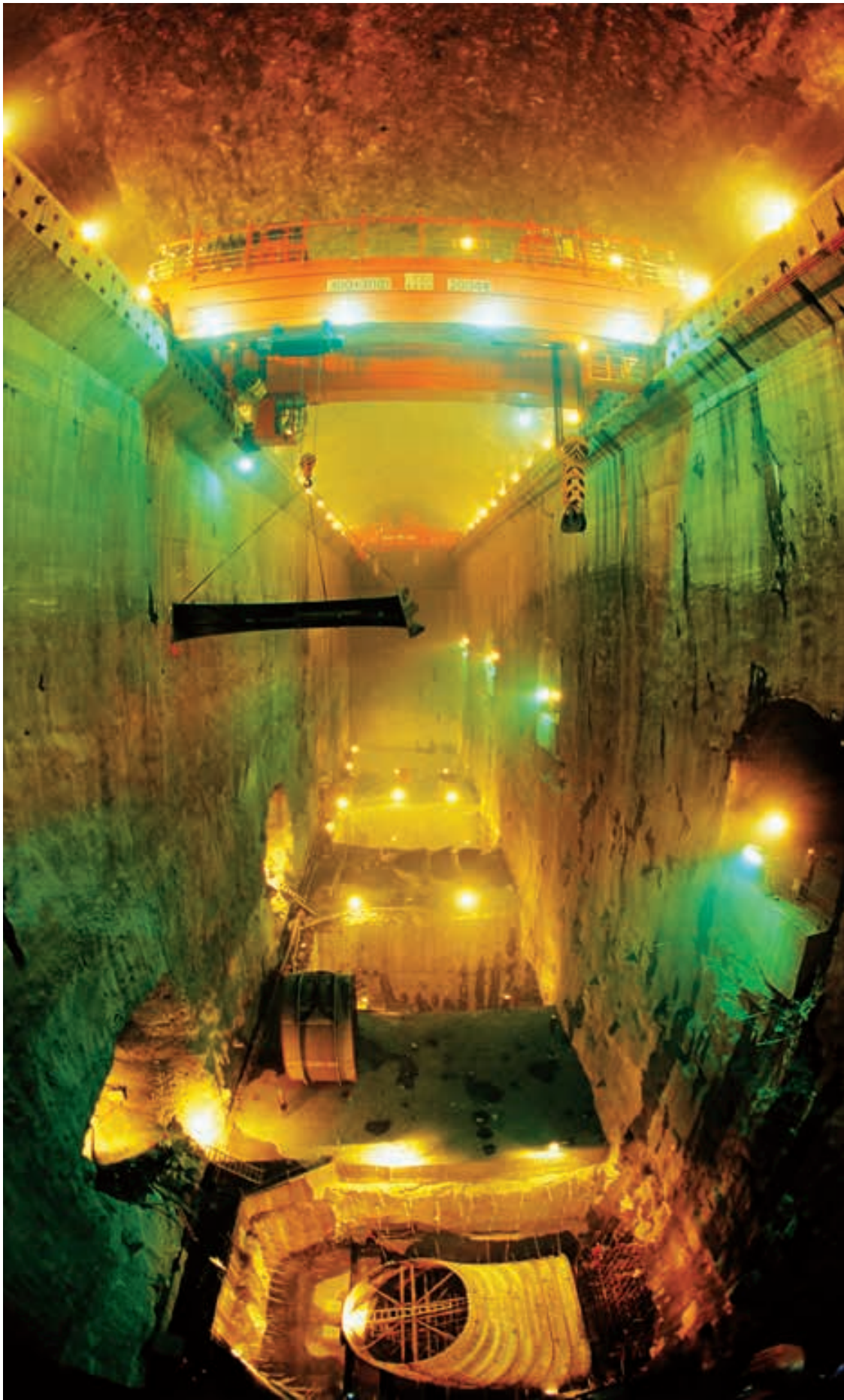
地下厂房施工
