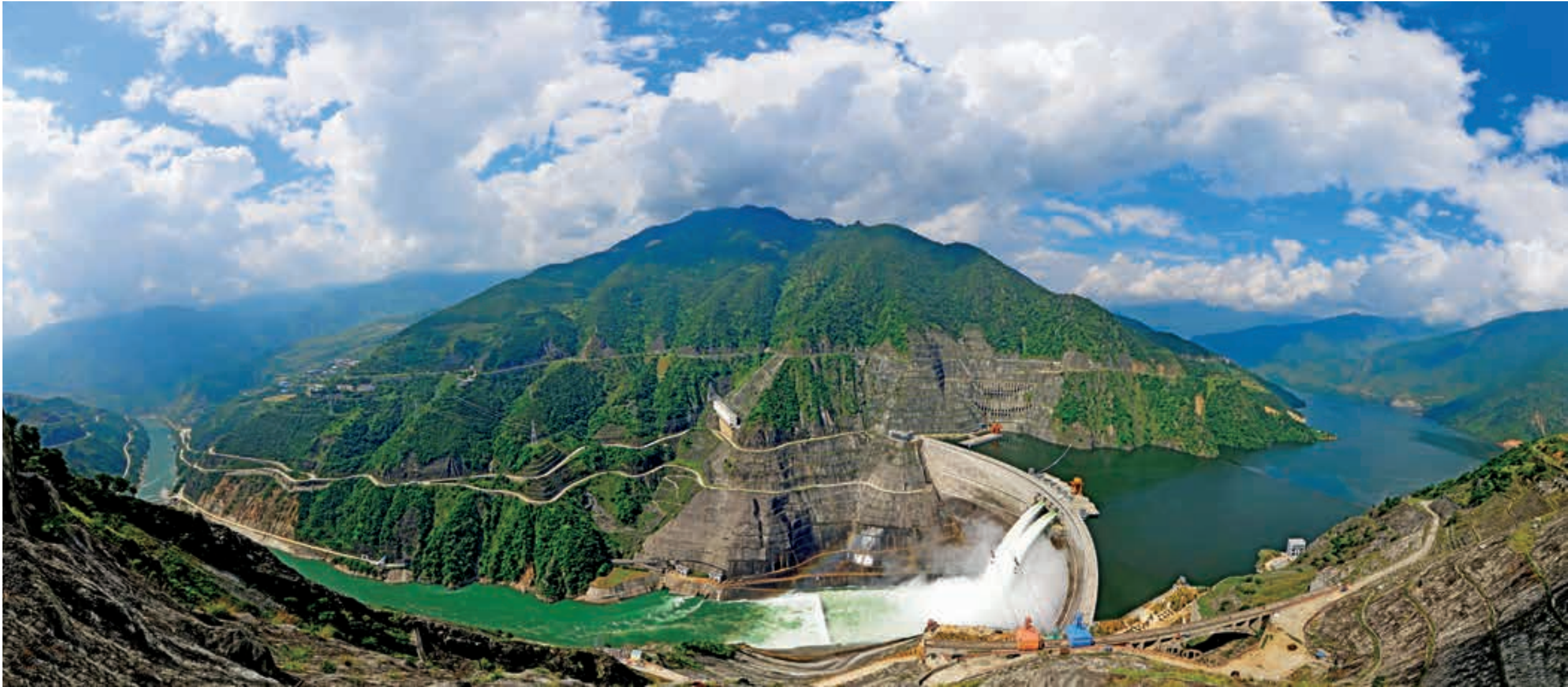
小湾特高拱坝泄洪全貌
