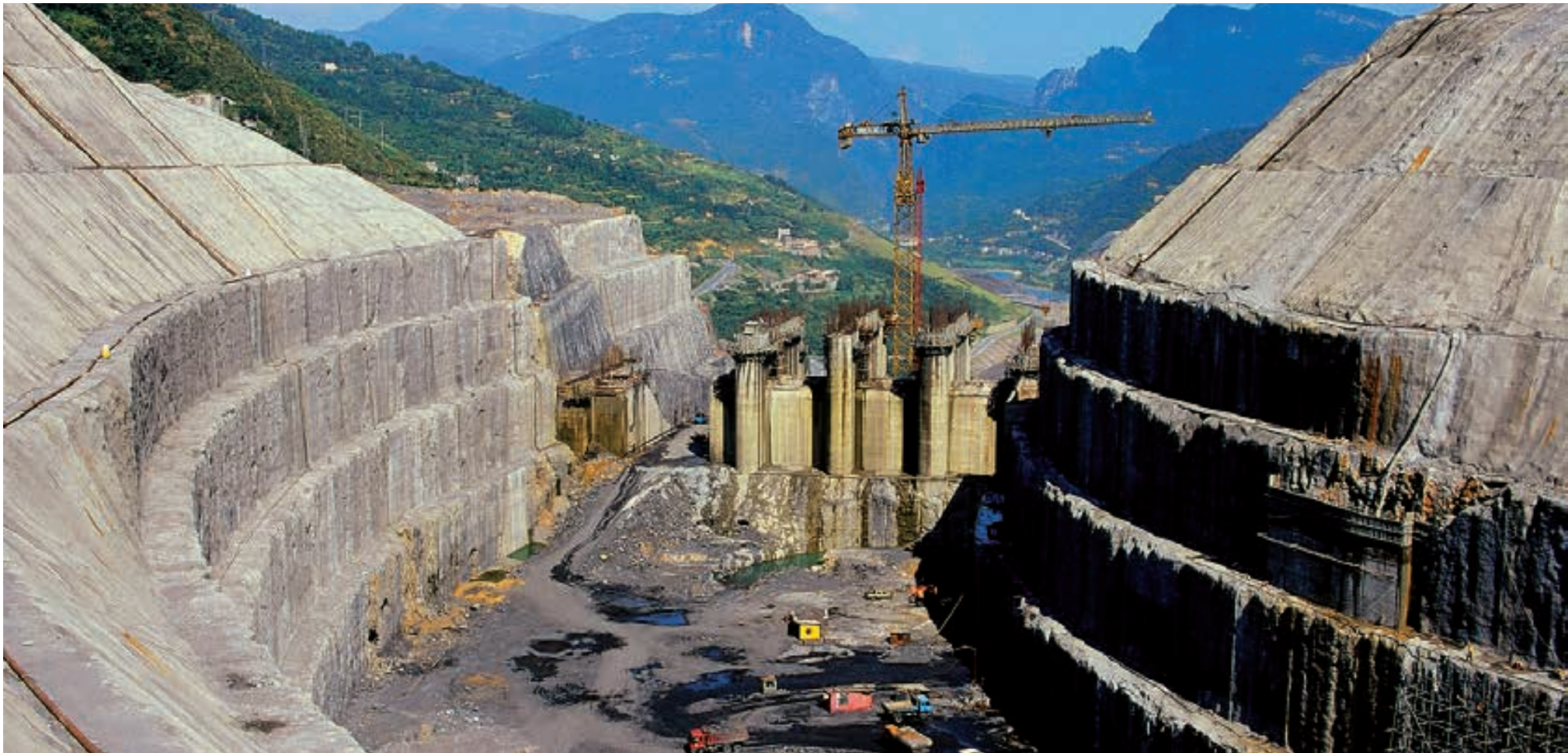
溢洪道开挖与浇筑
