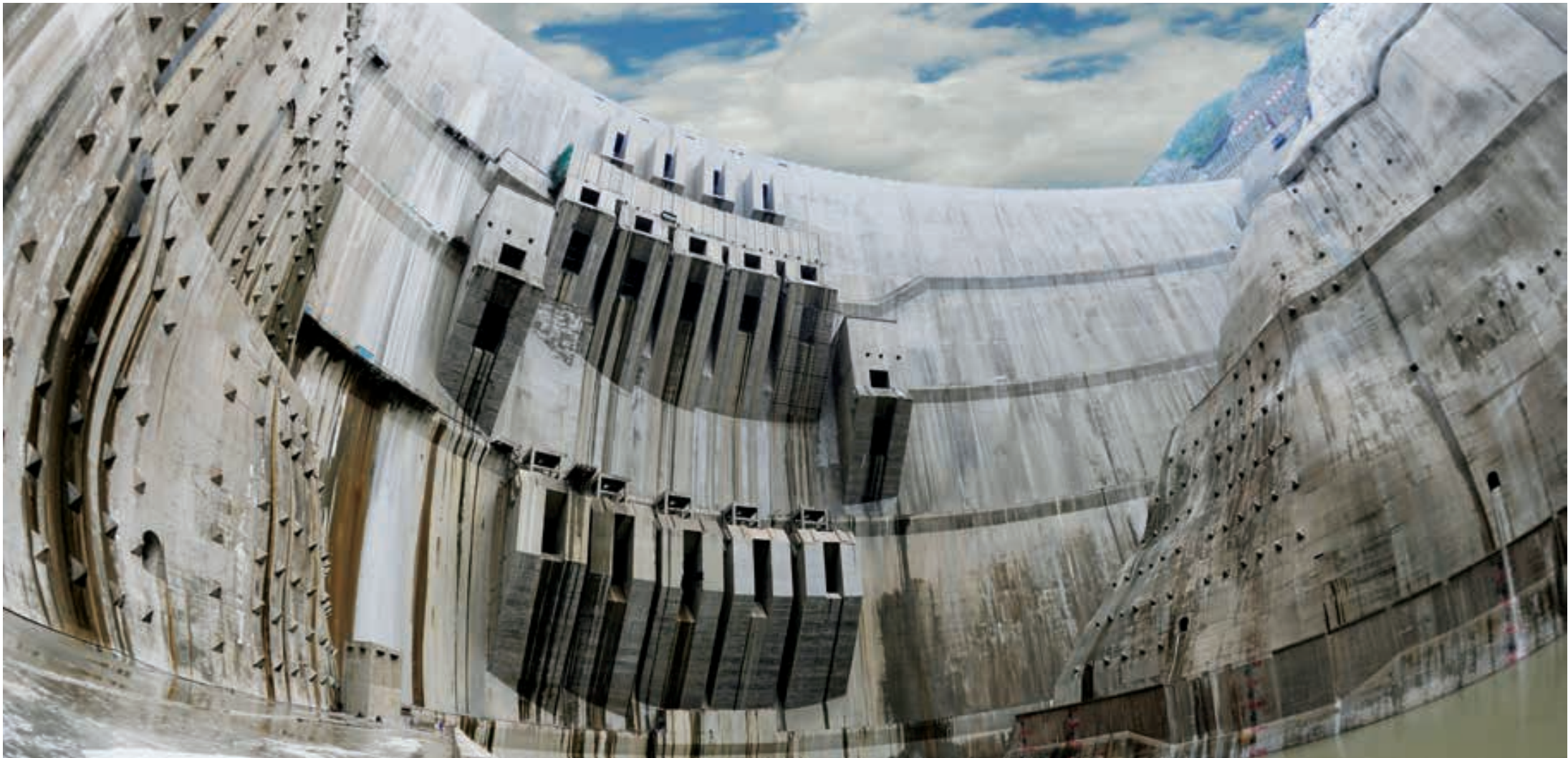
锦屏一级水电站大坝仰视图
