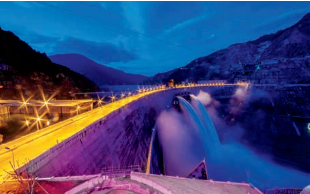
璀璨灯光下的小湾水电站夜景
