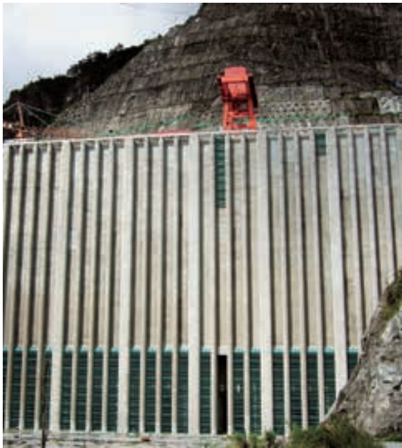
引水发电系统进水口
