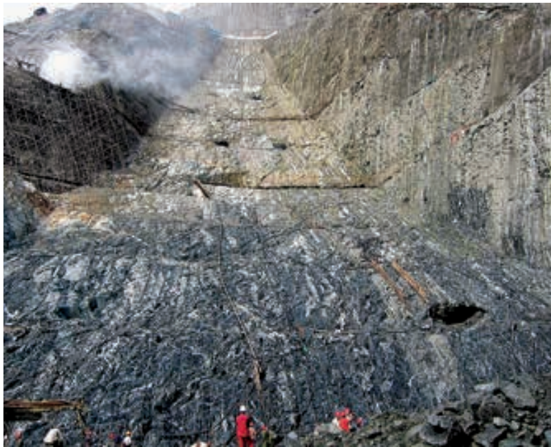
小湾边坡开挖工艺被谭靖夷院士称为“艺术品”
