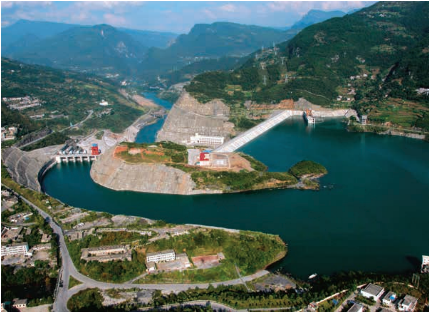
水电站上游全景
